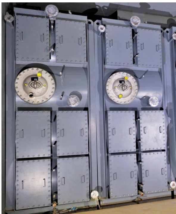
Schichtspeicher 200K mit Thermalwasserwärmetauscher
